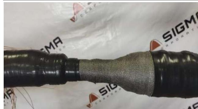
**14.** Надвинуть на жилу термоусаживаемую трубку большего диаметра на корешок кабеля. Произвести термоусадку трубы мягким пламенем горелки как показано на рисунке, не допуская образования складок и вздутий. Следует избегать остроконечного синего пламени. Постоянно перемещайте пламя во избежание пережога материала.
