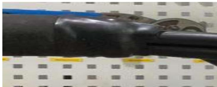
**3.5** С заходом на 25 мм на мастичную ленту 2228, с 50% перекрытием витков нанести 1 слой сетчатой ленты РЗФ. Края ленты зафиксировать лентой 23. Лента 23 наносится с большим натяжением и должна полностью покрывать мастичную ленту 2228.
