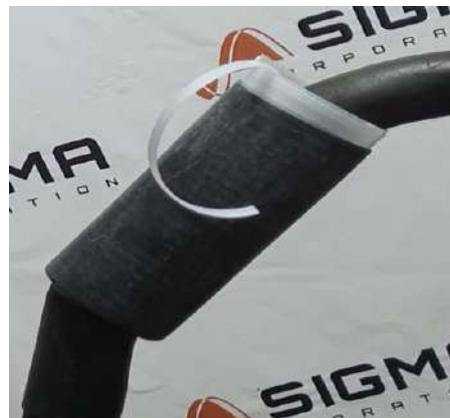
**3.8** Вскрыть бумажно-металлизированный пакет с компаундом руками, согласно инструкции на упаковке, не применяя острых предметов для вскрытия (ножей, ножниц и т.п.), произвести перемешивание двух компонентов компаунда в течение 30-60 секунд.
