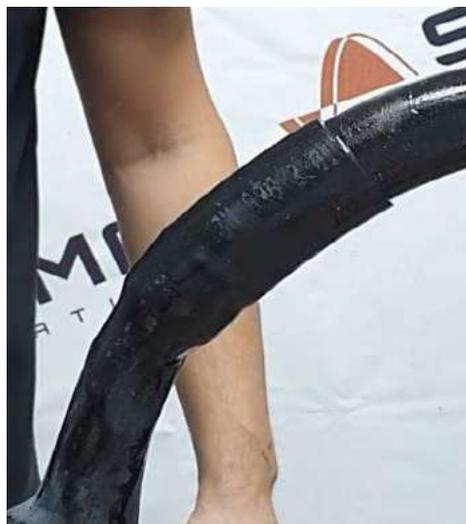
**3.11** Произвести намотку ленты VM на стык оболочек кабеля и ТХУ. Накотку производить с заходом на оболочку кабеля 20мм, на ТХУ 20мм.
